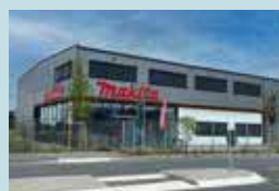
Makita Service-Center Groß-Gerau b. Frankfurt a. M.
